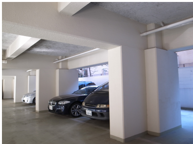
1 共用部1階ピロティ、駐車場
