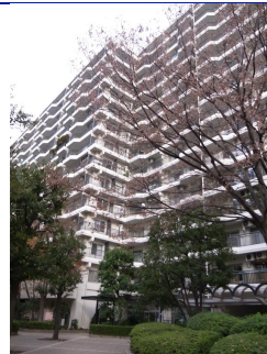
パークシティ溝の口（川崎市高津区）
