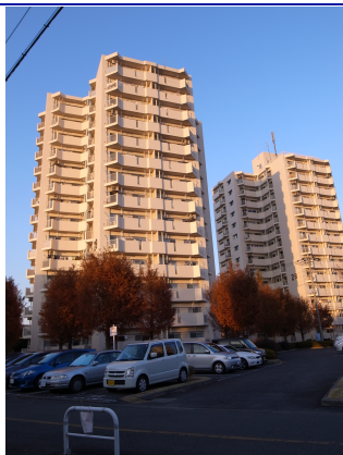
若葉台第一住宅（埼玉若葉台）
